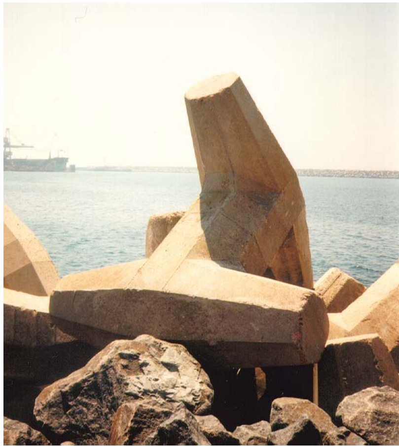
Vollständiger Dolos im Hafen von Sines, Portugal unzerstört
